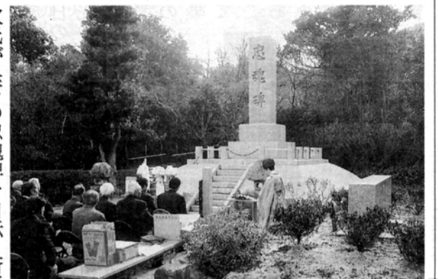
野洲支部忠魂碑改修工事の竣工式(平成24年3月)
