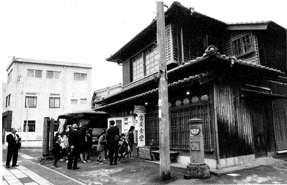
現存する富屋食堂の建物。鳥浜トメさんは特攻隊員から「おかあさん」と慕われた
